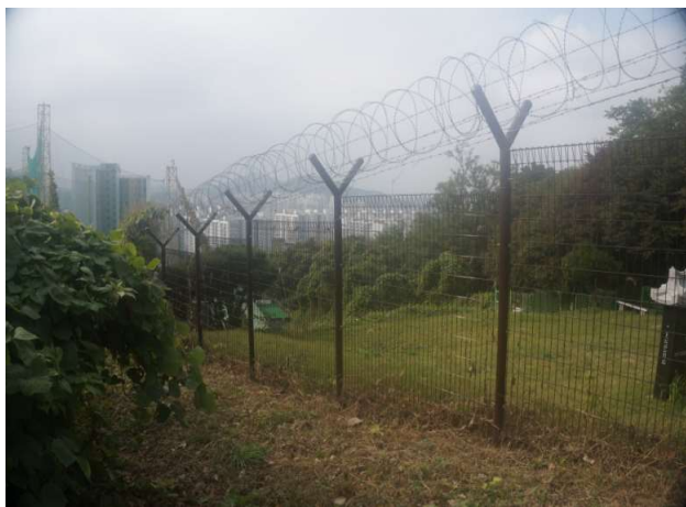
배수지 펜스 상태양호
