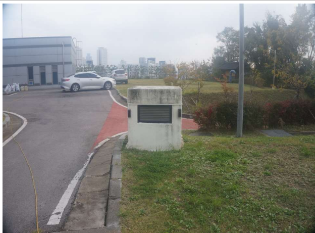
배수지1지 환기구 상태양호
