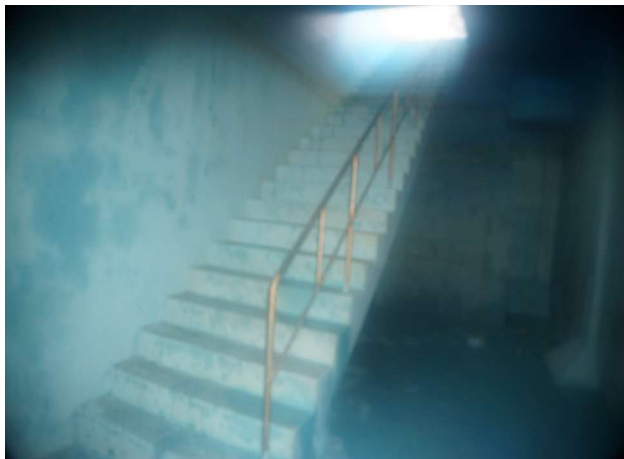
배수지 내부 안전난간 상태양호
