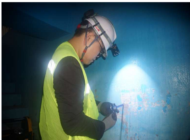
탄산화 깊이 측정
