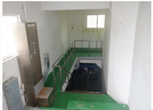
유입검수실 내부 안전난간 상태양호
