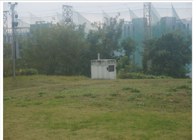
배수지1지 환기구 상태양호
