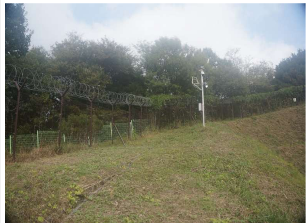
배수지 펜스 상태양호
