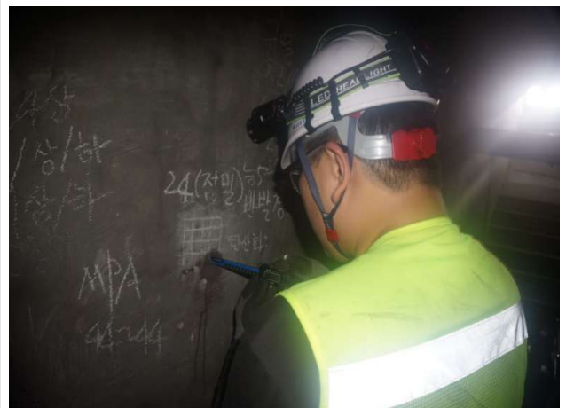
탄산화 깊이 측정
